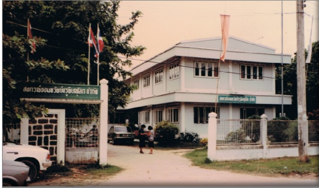
อาคารสำนักงานที่สร้างในปี 2513
